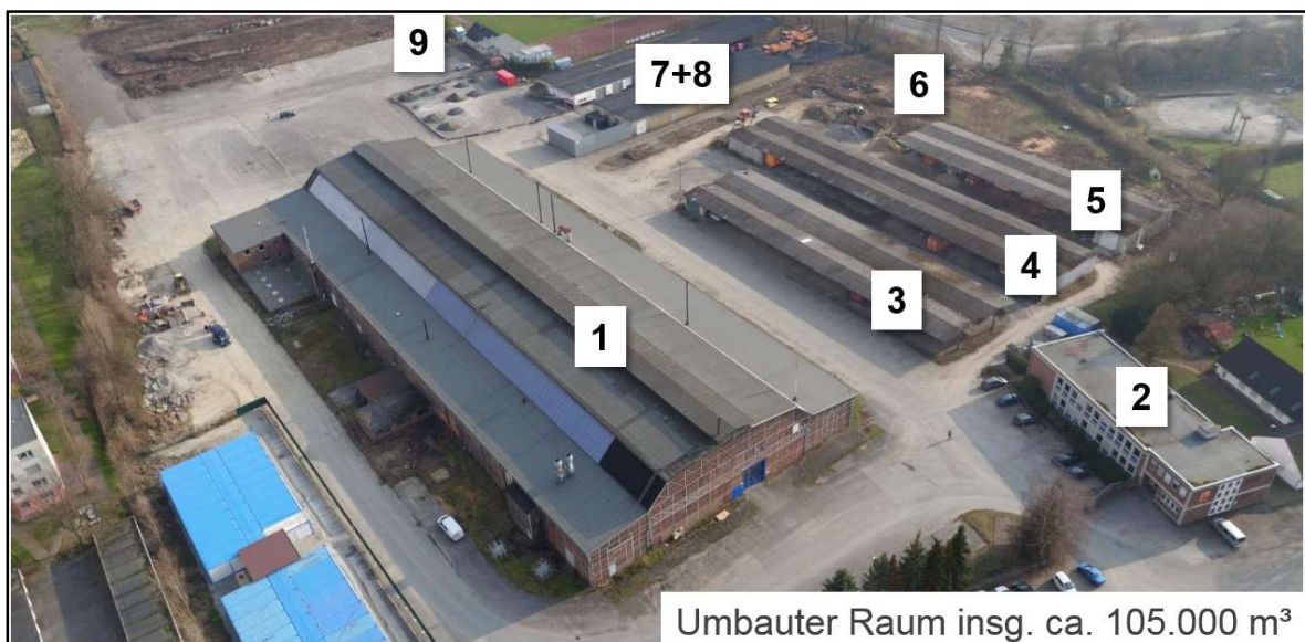
Abbildung 4: Bebauung des STRABAG-Areals bis Mitte 2018
