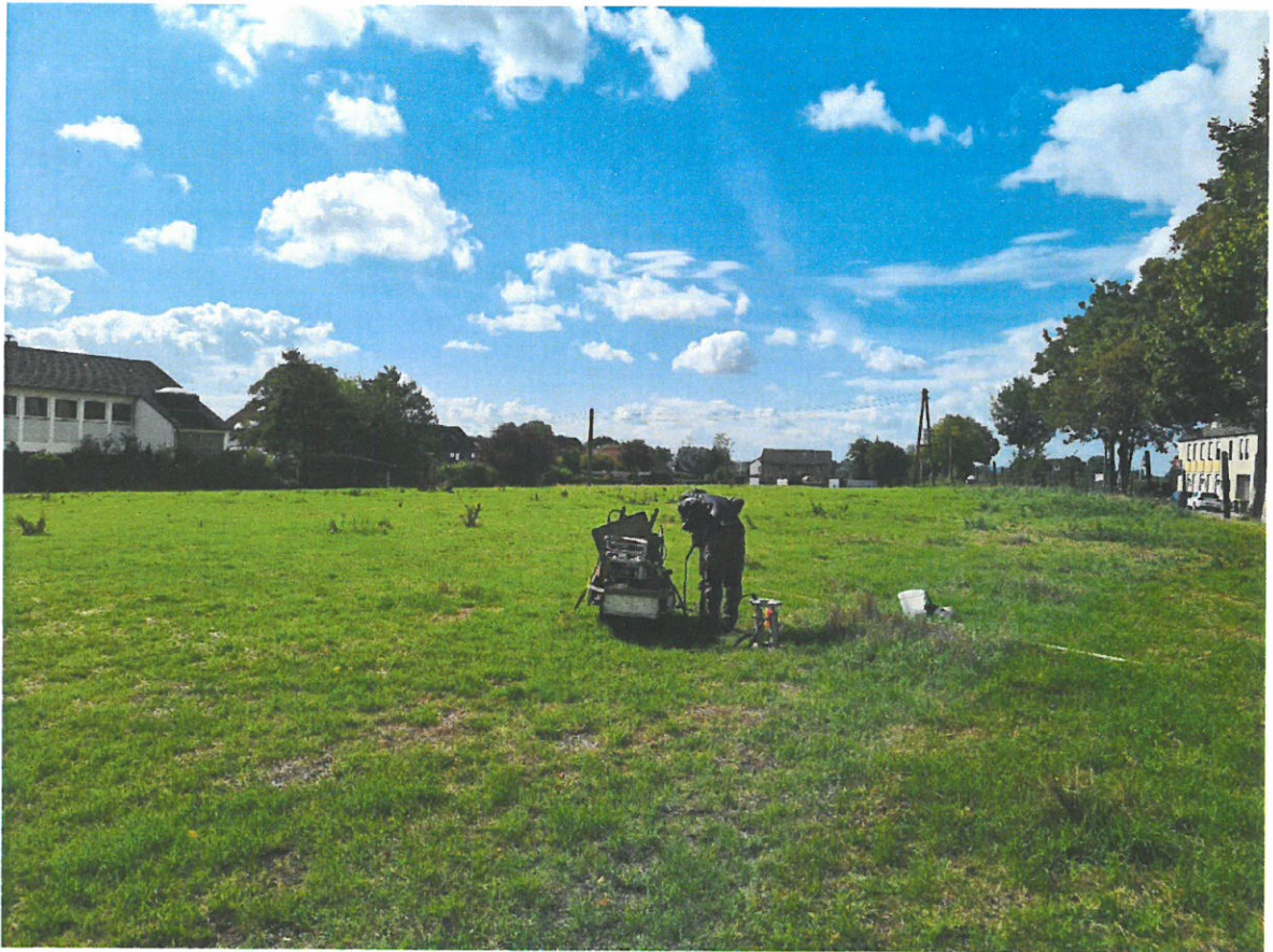
Bild 7: Ausführung RKS 3 mit Vorbereitung V2 am 19.09.2022
