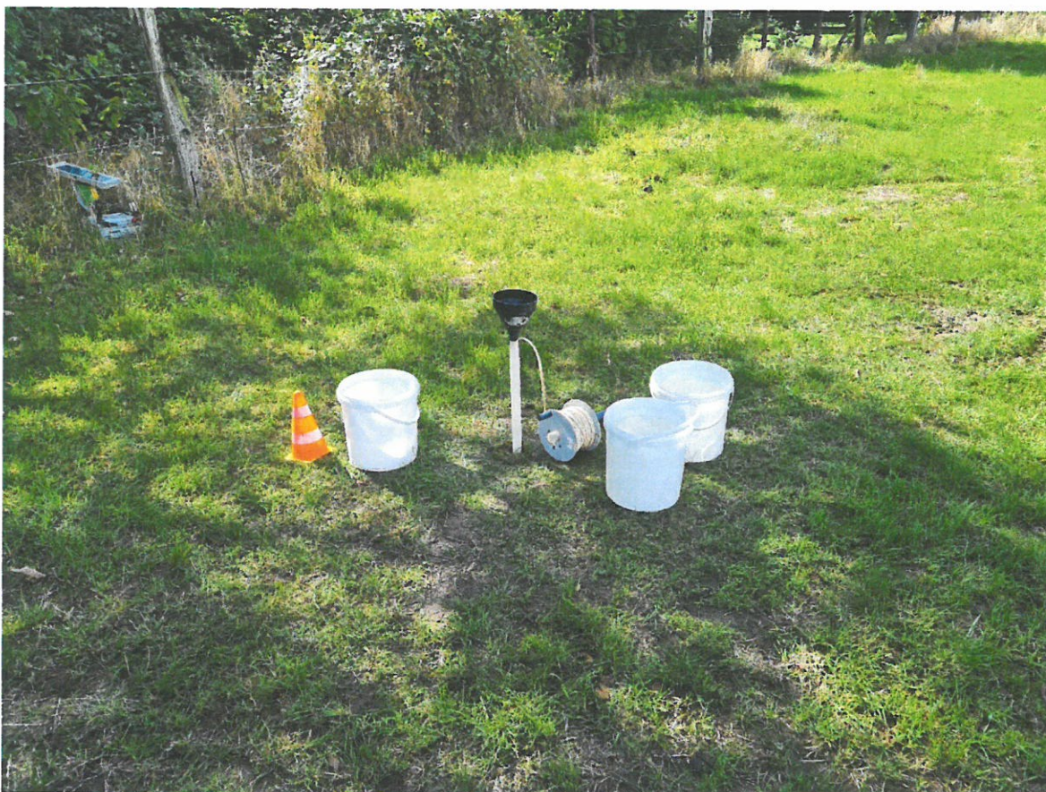
Bild 9: Ausführung V1 im Bohrloch der RKS 2 am 19.09.2022
