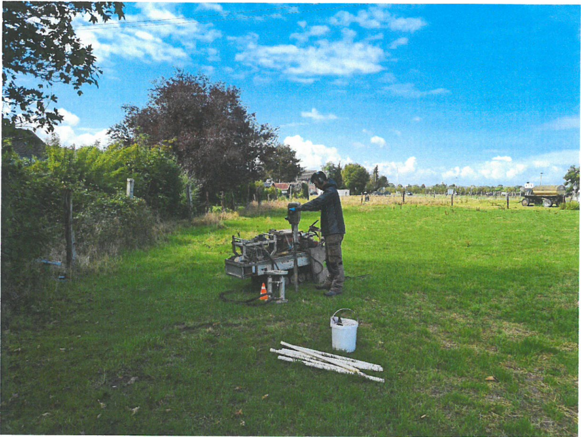
Bild 5: Ausführung RKS 2 mit Vorbereitung V1 am 19.09.2022
