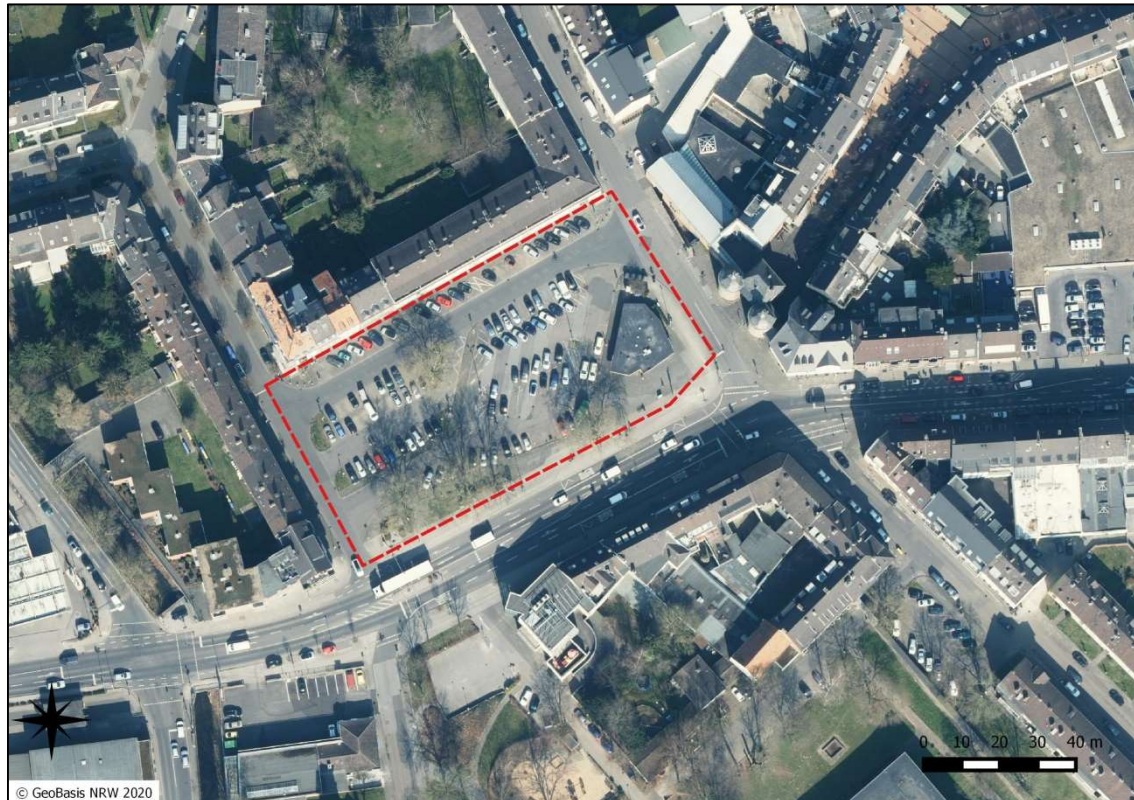
Abb. 2: Lage im Luftbild mit dem vorhandenen Gebäude und der Gehölzbestockung.
