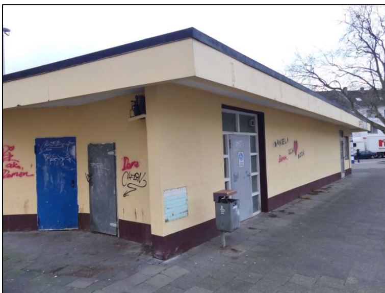
Abb. 6: Ehemaliges Kiosk- und Toilettengebäude.
