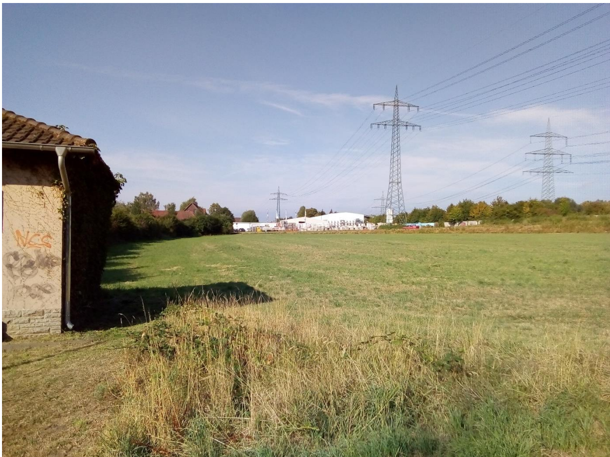
Abbildung 2: Aktuelle Situation im Plangebiet (Quelle: Eigene Aufnahme)
