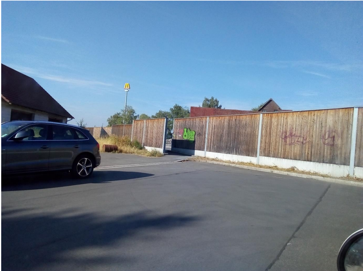
Abbildung 5: Lärmschutzwand im Süd-Westen des Plangebiets (Quelle: Eigene Aufnahme)
