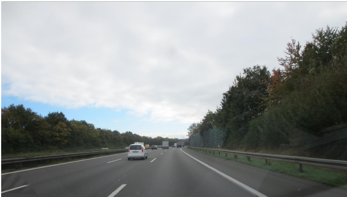
Beispielhaft: L 333 Blickrichtung Ost in Höhe Heinrich-Busch-Straße
