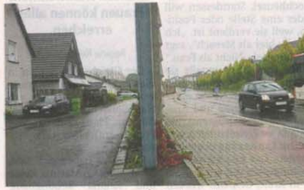
Lärmschutz am Fumberg an der Südumgehung.
