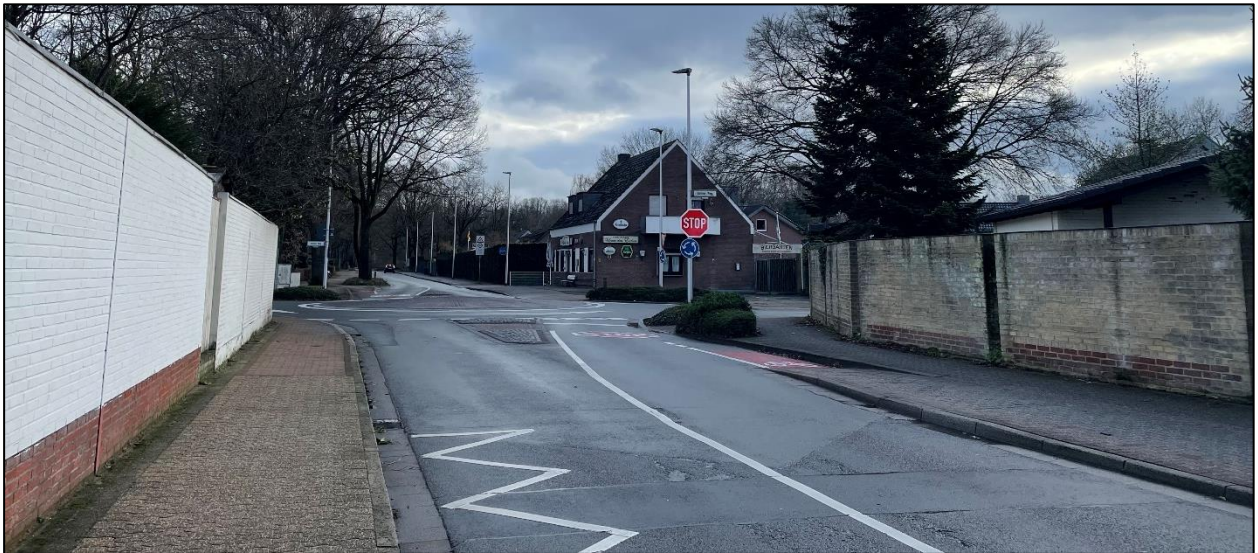
Abbildung 5: Derzeitige Situation des Knotenpunktes Unter den Eichen / Burloer Weg, Blickrichtung Südosten
