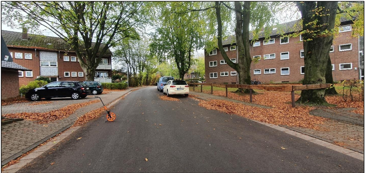
Abbildung 4: Derzeitige straßenräumliche Situation der Buchenallee, Blickrichtung Südosten
