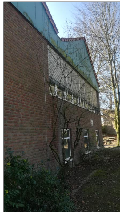
Abb. 7: Nordwestliche Giebelseite des ehemaligen Schulgebäudes.
