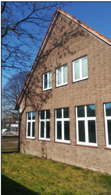
Abb. 6: Südöstliche Giebelseite des ehemaligen Schulgebäudes.
