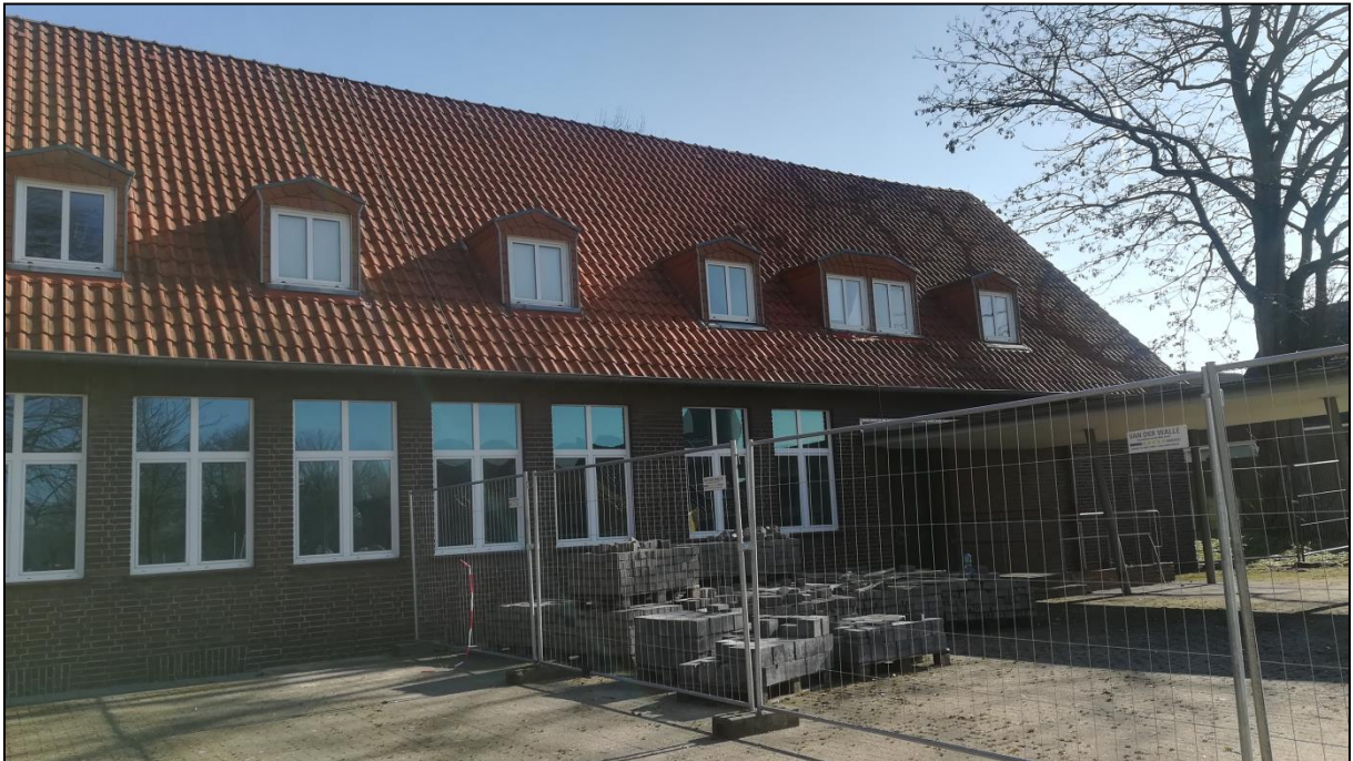
Abb. 4: Südwestfassade des ehemaligen Schulgebäudes.
