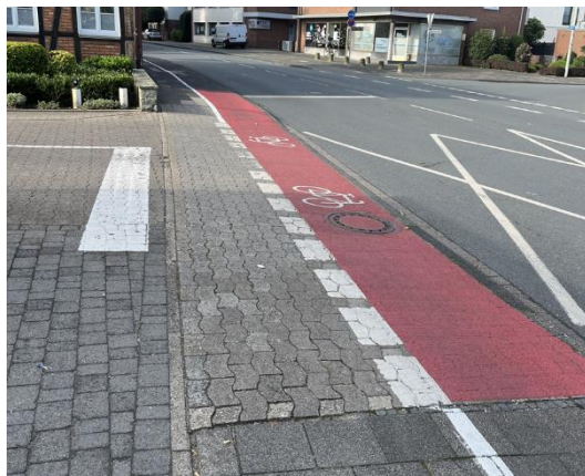
Gemeinsame Führung im Seitenraum, fehlende taktile Trennung, Freckenhorster Str.
