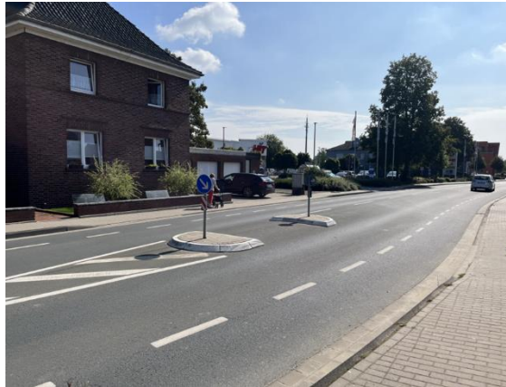
Fehlende taktile Auffindbarkeit der Querungshilfe, Splieterstr.
