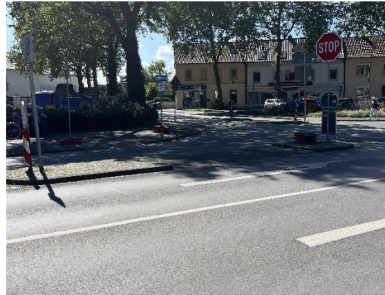
Fehlende taktile Auffindbarkeit sowie Aufstellfläche der Mittelinsel, Münsterstr.
