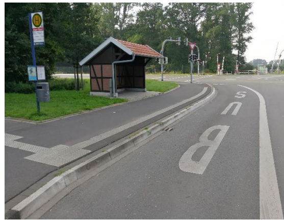
Barrierefrei ausgebaute Haltestelle am Bahnhof Einen-Müssingen
