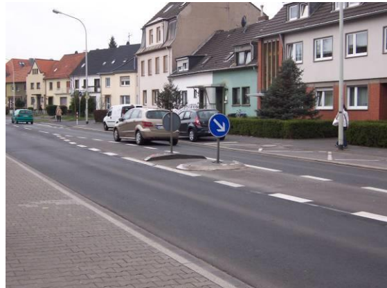
Provisorische Querungssicherung nördlich Chlodwigstraße
