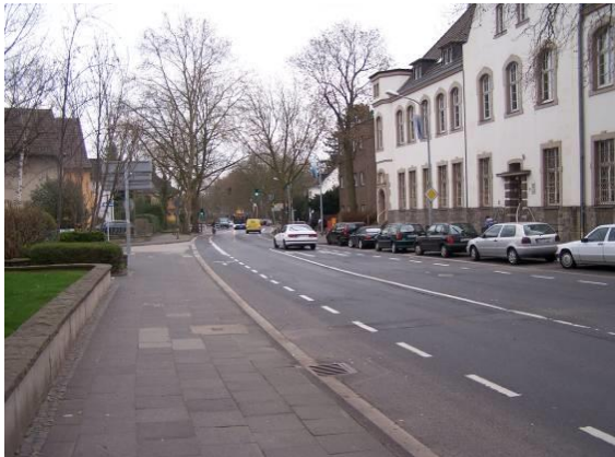
Blick Richtung Osten auf Einmündung Poststraße
