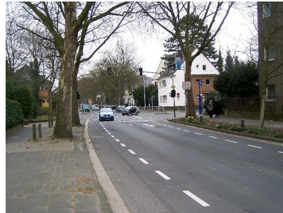
Blick auf Knotenpunkt Comesstraße/Wilhelmstraße/ Mayersweg
